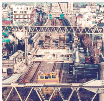
山陽新幹線橋げたの落下
