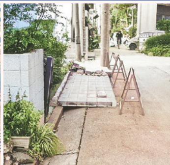
ブロック塀の倒壊
