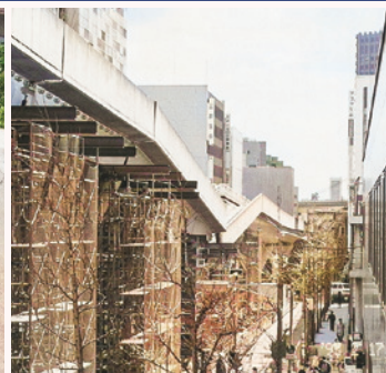
新交通システム橋げたの変形
