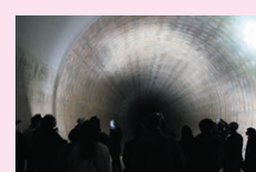
■環状七号線地下調節池見学
